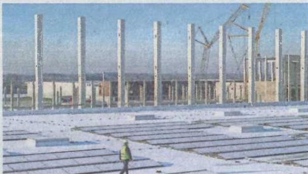
Bis zu 35 Meter sind die Hallenträger hoch. Die Dachträger aus Beton haben eine Länge von 52 Metern.
