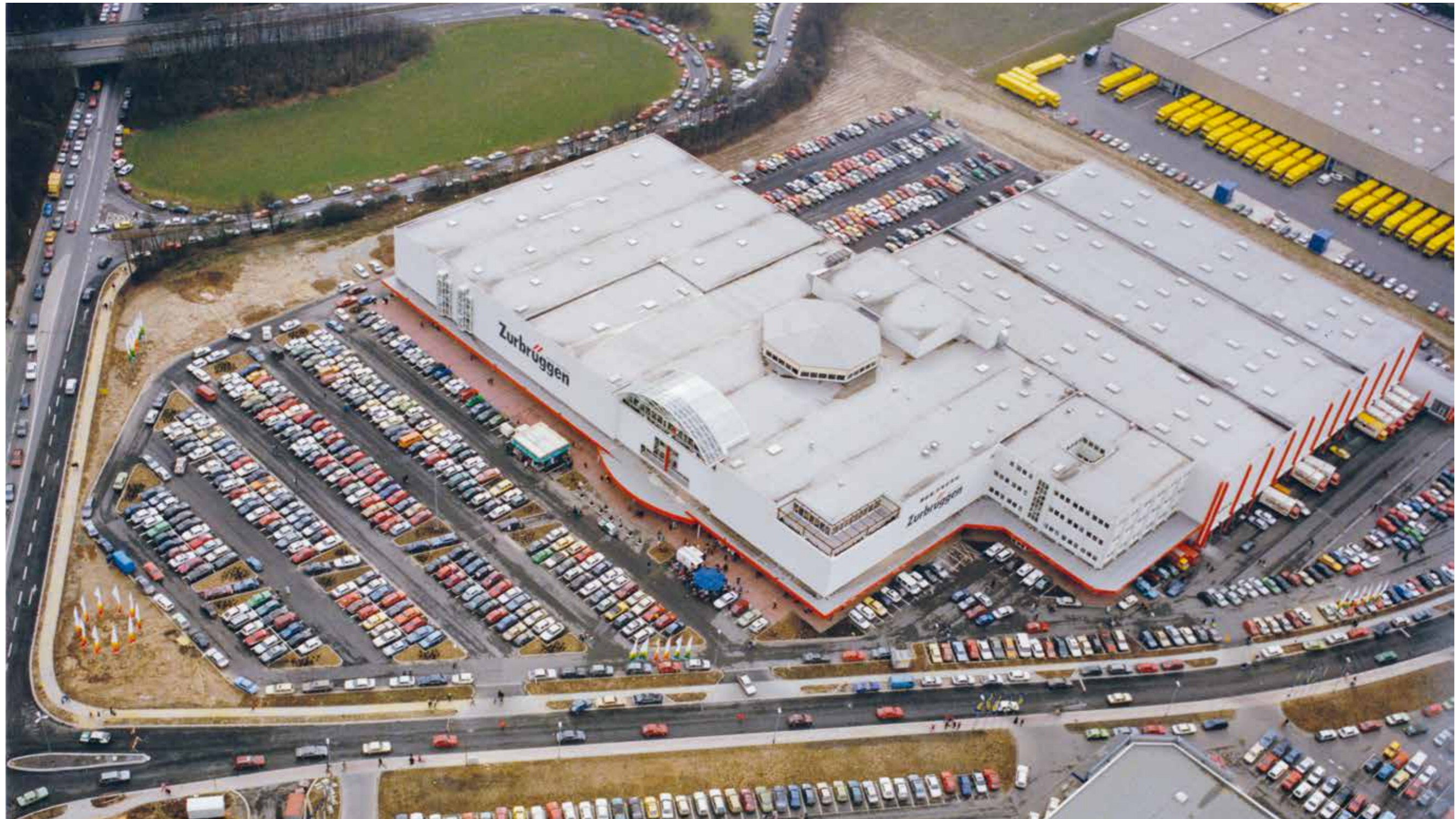
Luftaufnahme des neuen Verkaufshauses Zurbrüggen in Unna.
