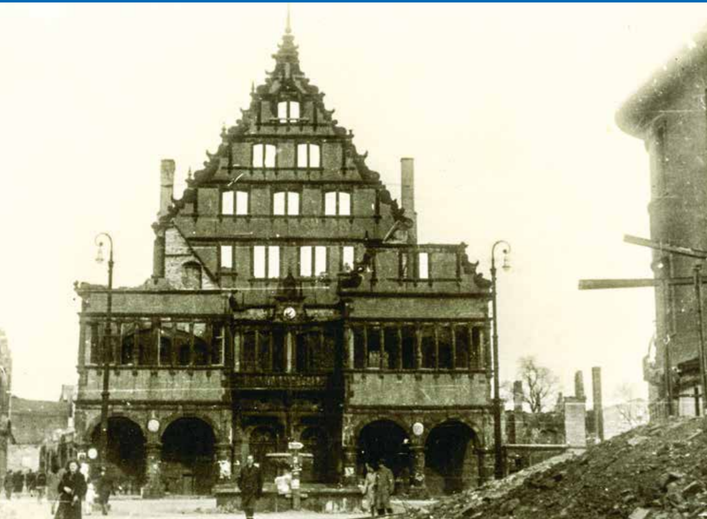
Zerstört durch Bombenschäden infolge der Luftangriffe – das Paderborner Rathaus.
