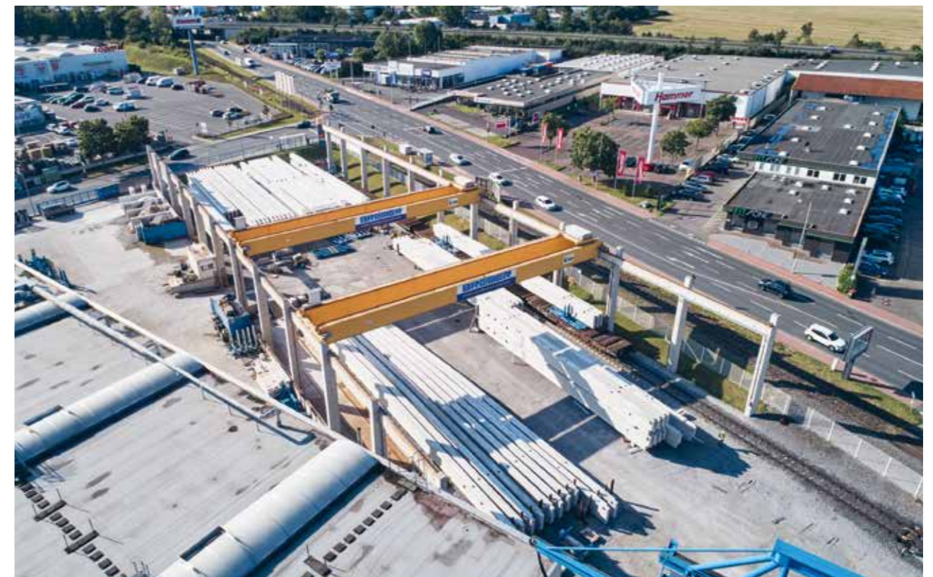
Die Bahnverladung auf dem Werksgelände der BREMER AG. Im Hintergrund ist die Frankfurter Straße zu sehen.
