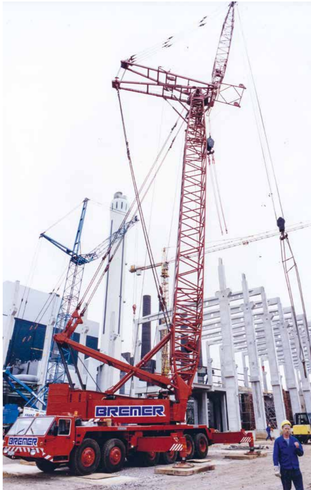
Die Baustelle PM1 in Hürth, 2001.
