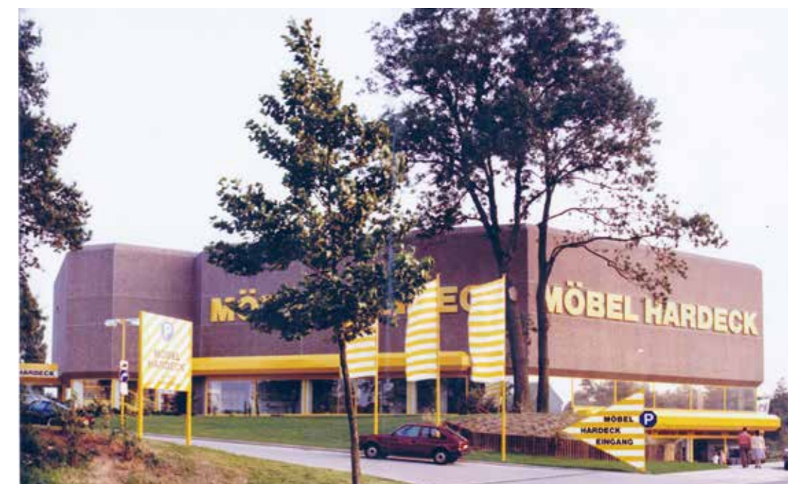
Möbel Hardeck – erste Schritte in Richtung schlüsselfertiges Bauen bei BREMER. Abgewickelt wurde der Achteckbau von Josef Ellebracht, Kopf von BREMERs neuer Abteilung: „Schlüsselfertiges Bauen“.
