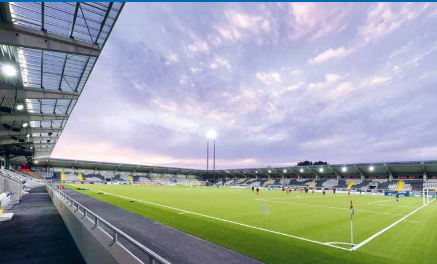
Das Stadion Rambergsvallen in Göteborg wurde 2014/15 von BREMER gebaut – heute trägt es den Namen „Bravida Arena“.
